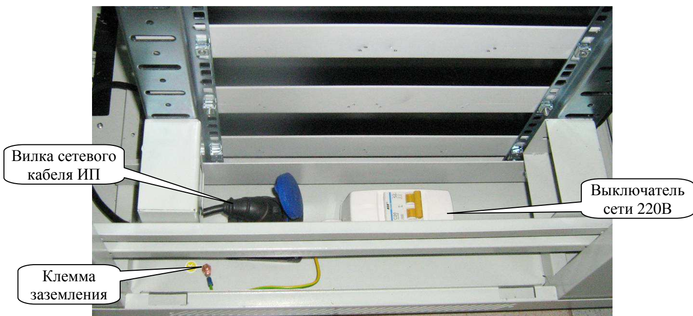
Рисунок 3 Подключение сетевого напряжения
